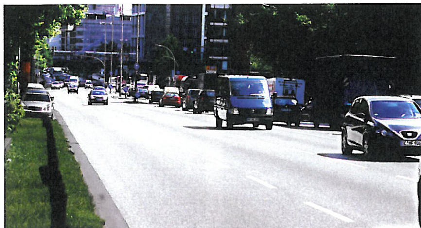
Bild 2: Aufgehellte Stadtstraße mit schwarzem Gussasphaltwasserlauf
