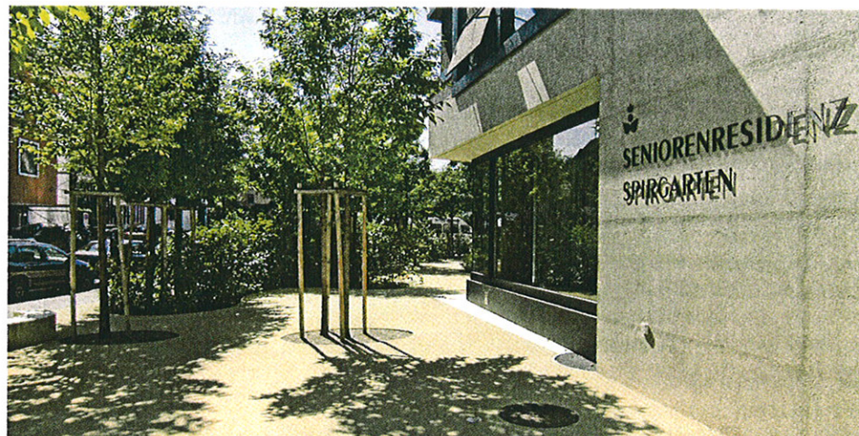
Ohne Zusatz von Farbpigmenten wird die natürliche Farbe des eingesetzten Mineralstoffes besonders zur Geltung gebracht. Fotos: Thomas L. Fischer. Sans ajout de colorant, les couleurs naturelles des éléments composant le revêtement sont particulièrement mises en évidence.
